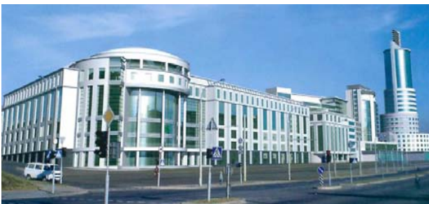
201X новое здание головного офиса ОАО «АСБ Беларусбанк» (в процессе строительства)
