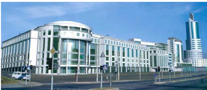
201X Новое здание Головного офиса ОАО «АСБ Беларусбанк» (строительство)
